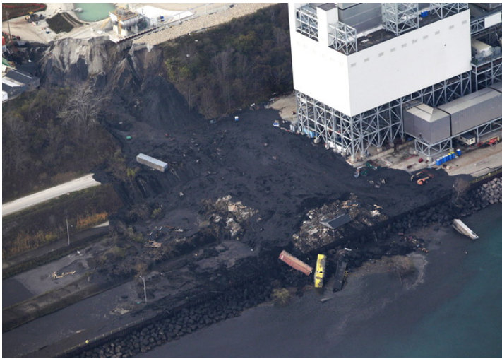
Oak Creek Spill
